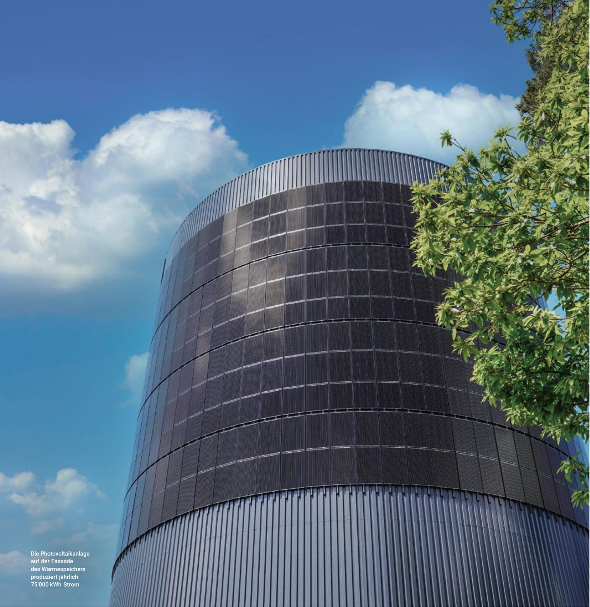
Die Photovoltaikanlage auf der Fassade des Wärmespeichers produziert jährlich 75'000 kWh Strom.
